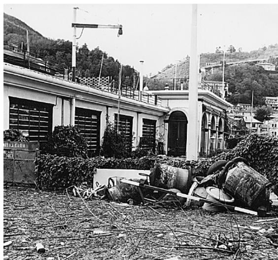
Fig. 11 Danni da esondazione
