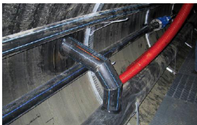
Fig. 15 Gallerie tecnologiche multiservizi. Particolare di allacciamento utenze
