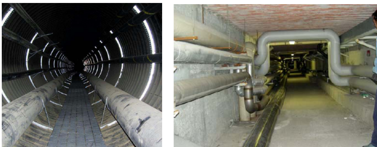
Fig. 14 Gallerie tecnologiche multiservizi
