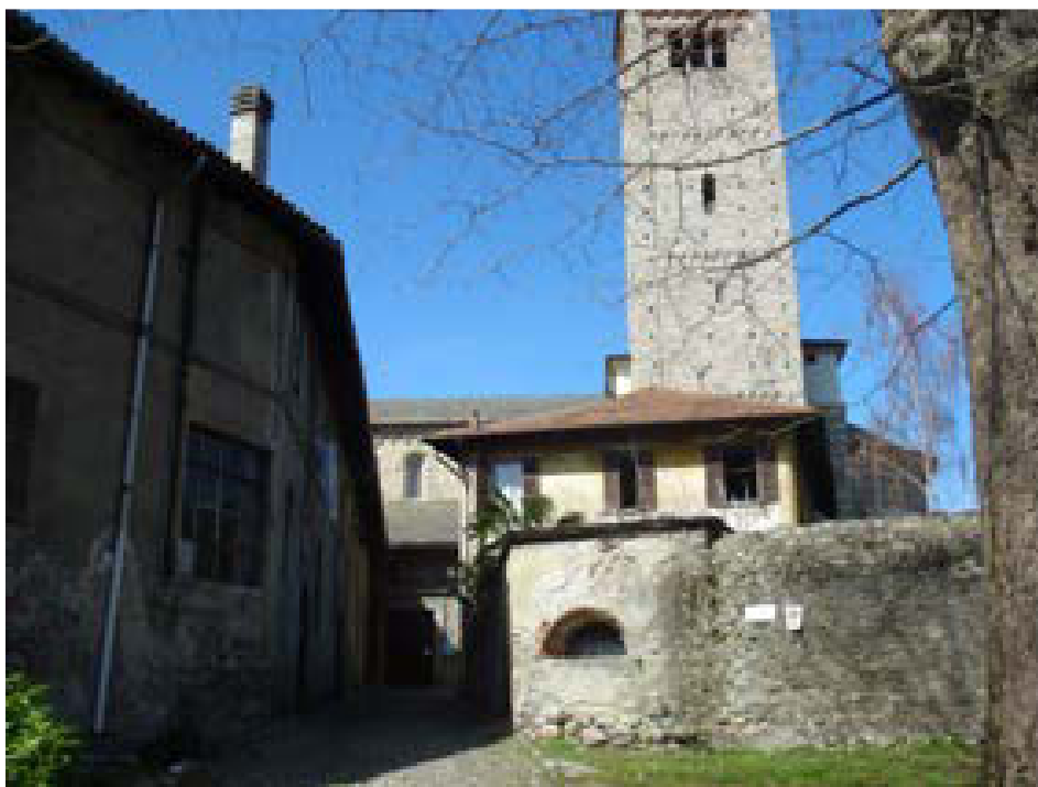
Como, chiesa di S. Carpofo, prospetto sud (stato attuale)
