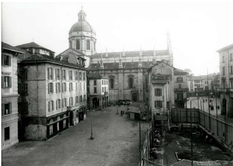
Cantiere della nuova sede della Banca Commerciale (1924). In secondo piano si riconoscono i fabbricati addossati alla torre del Broletto.
