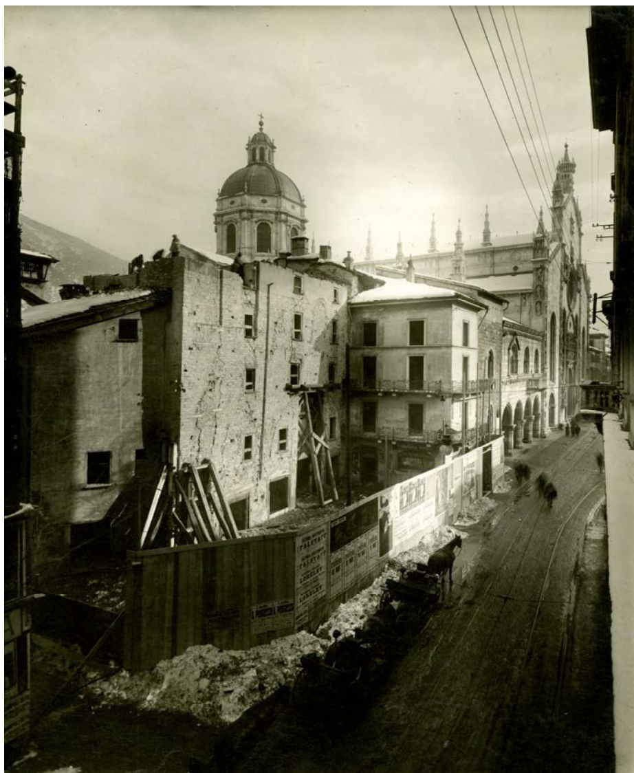
Opere di demolizione dei fabbricati addossati alla torre del Broletto (1924-1925). La parte sommitale della torre sarà ricostruita nel 1927 a cura dell'arch. F. Frigerio.
