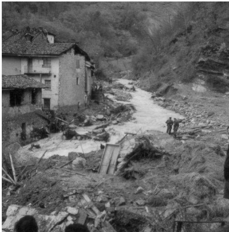
Figura 5 – Fotografia del T. Cosia a seguito dell'alluvione del 1951, all'altezza del ponte di via Diaz in comune di Tavernerio (fonte: sito comune Tavernerio)
